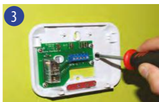
3 Βιδώστε το οπίσθιο τμήμα του δέκτη στον τοίχο, χρησιμοποιώντας τις παρεχόμενες βίδες εγκατάστασης.
