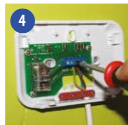
4 Свържете кабелите в съответствие със схемата, съответна за Вашата отоплителна система.
