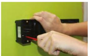
**7** Spojite vodiče napajanja ekstenzora na kontakte N i L kako je pokazano na slici ispod.
