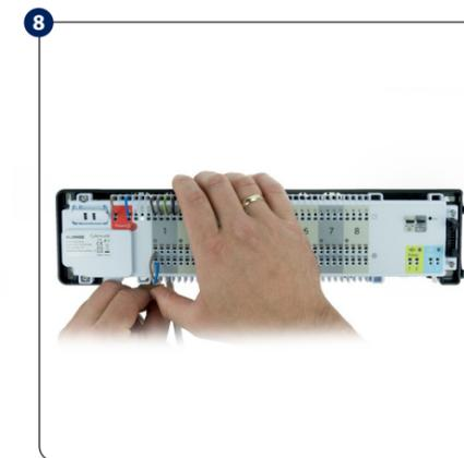
Connectez les fils des actionneurs thermique.
