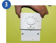
**3** Sobald die Verbindung besteht schieben Sie den Thermostat einfach von oben auf die Rückplatte auf.
