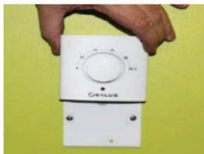
Sobald die Verbindung besteht schieben Sie den Thermostat einfach von oben auf die Rückplatte auf.
