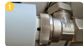
Montați capul TRV pe robinet
